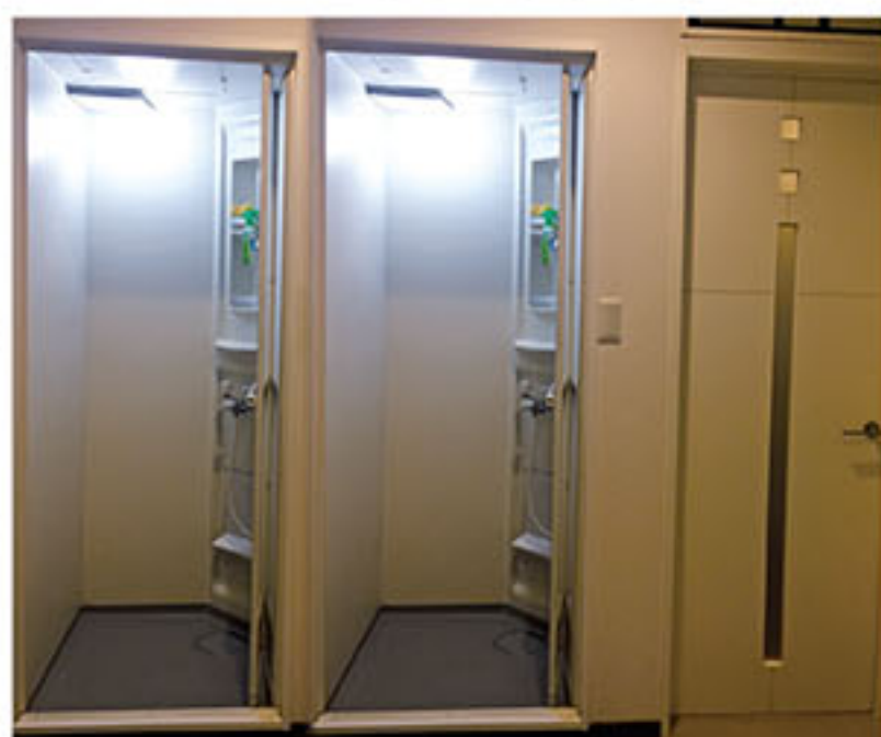
▲シャワー個室(扉付き)2室(シャワー4台)
